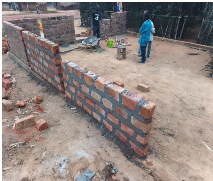
Nya kyrkan under uppbyggnad
